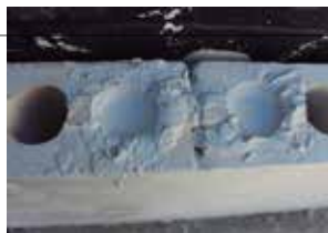
Blocos preenchidos com gesso-cola funcionam como colunas de uma parede estrutural
