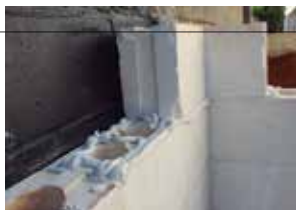
Blocos preenchidos com gesso-cola funcionam como colunas de uma parede estrutural
