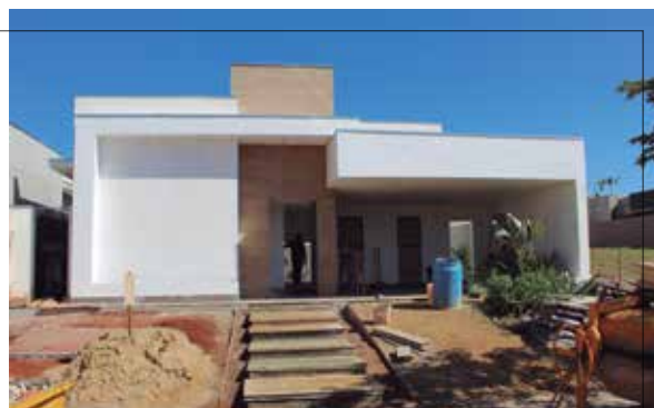
Casa em construção com blocos de gesso em condomínio
