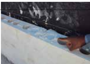
Blocos preenchidos com gesso-cola funcionam como colunas de uma parede estrutural
