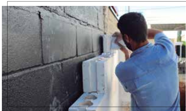
Gesso-cola faz a liga entre os blocos de gesso
